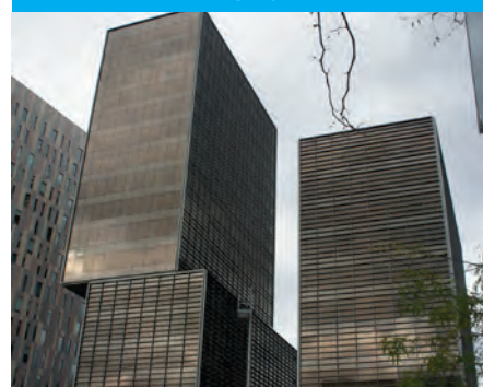
EDIFICIO DE OFICINAS CUATRECASAS (BARCELONA)
