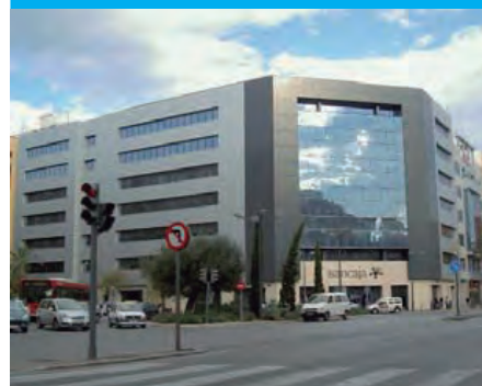
EDIFICIO CENTRO DE CÁLCULO BANCAJA (VALENCIA)
