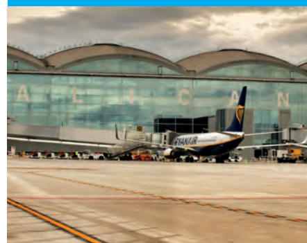
AEROPUERTO DE ALICANTE
